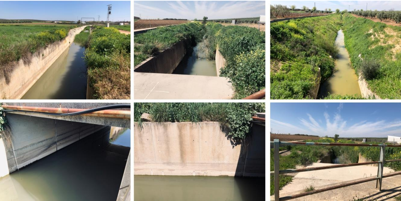
Imágenes del estado actual del canal 2. Elaboración propia
