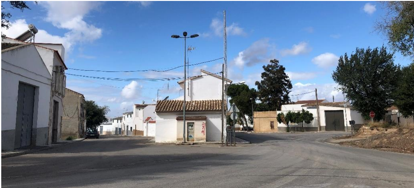
Problemática de borde urbano en el núcleo de Matarredonda
