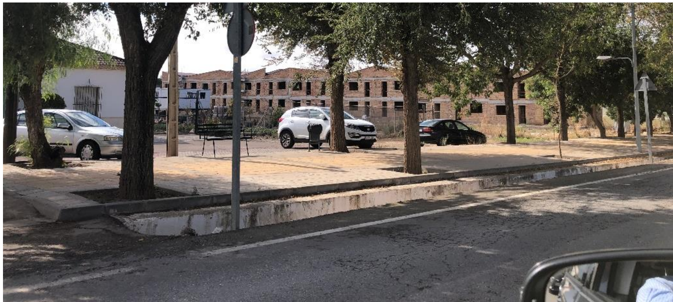
Sistema de cunetas en Carretera A-388
