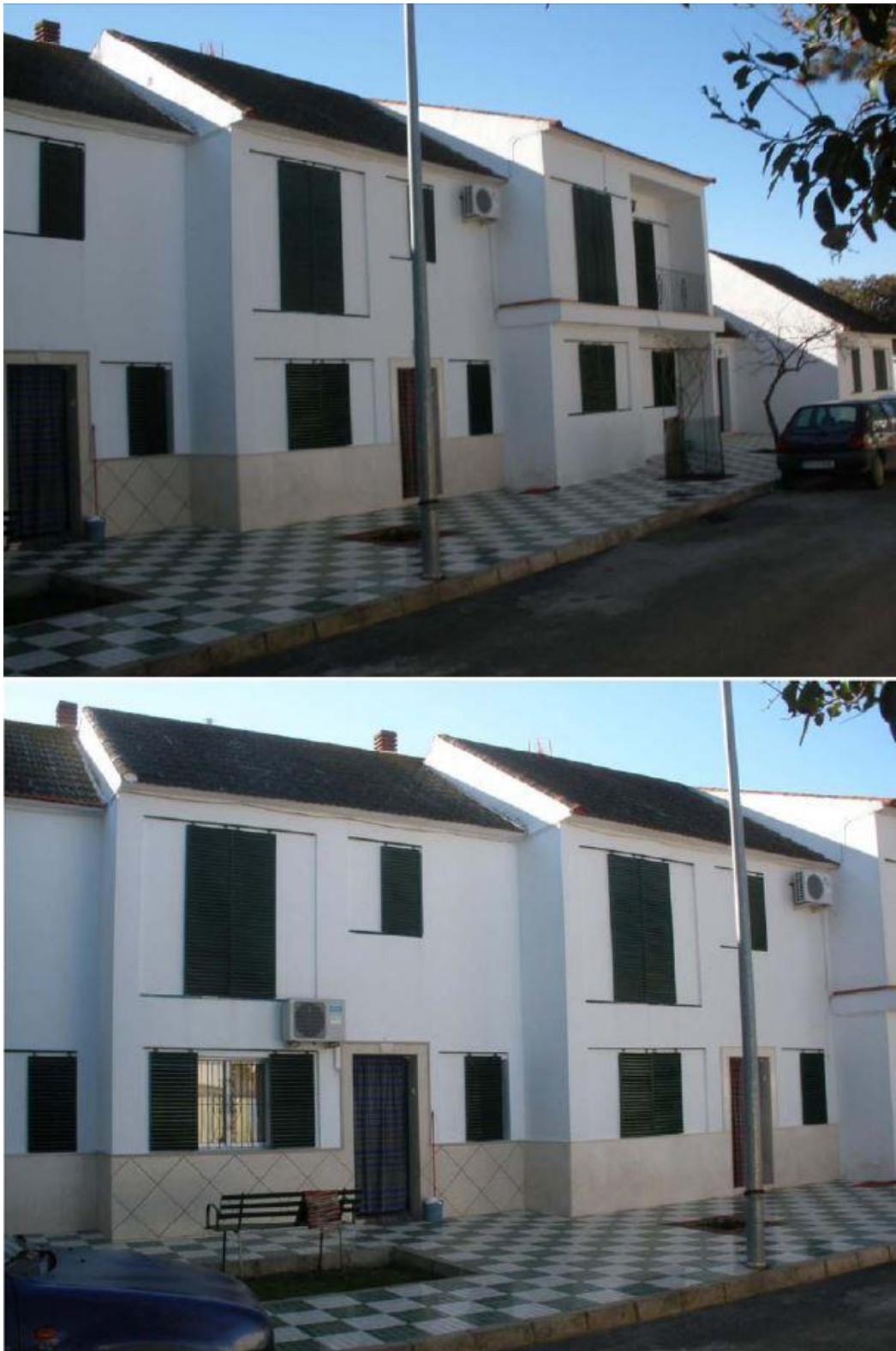
Viviendas de la barriada La Paz
